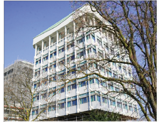
Die Fassade an Turm I ist fast fertiggestellt. Das Gerüst wurde bereits zurückgebaut. (Foto: © Stadt Marl)
